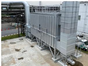
研磨フィルム等を製造する際、コーティングの乾燥工程から発生する有機溶剤ガス（揮発性有機化合物：VOC）を集め、燃焼することにより無害化する装置です。燃焼時の余熱は、廃熱ボイラを通して蒸気を生じさせ工場熱源として利用
