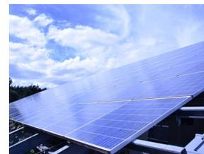
現在、北杜事業所屋根及びパネルラックに装備、公称最大出力120kWの性能を有しています。新たに設置予定で、1年間で750,790kWhの発電量が期待
